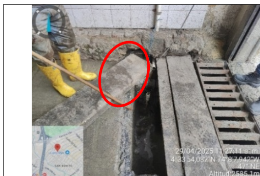
Fotografía No. 1. Tubería faltante
